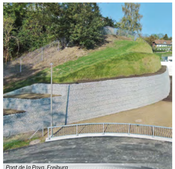
Pont de la Poya, Freiburg
